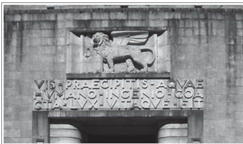
Sedico, località La Stanga - Centrale idroelettrica epigrafe del 1943
