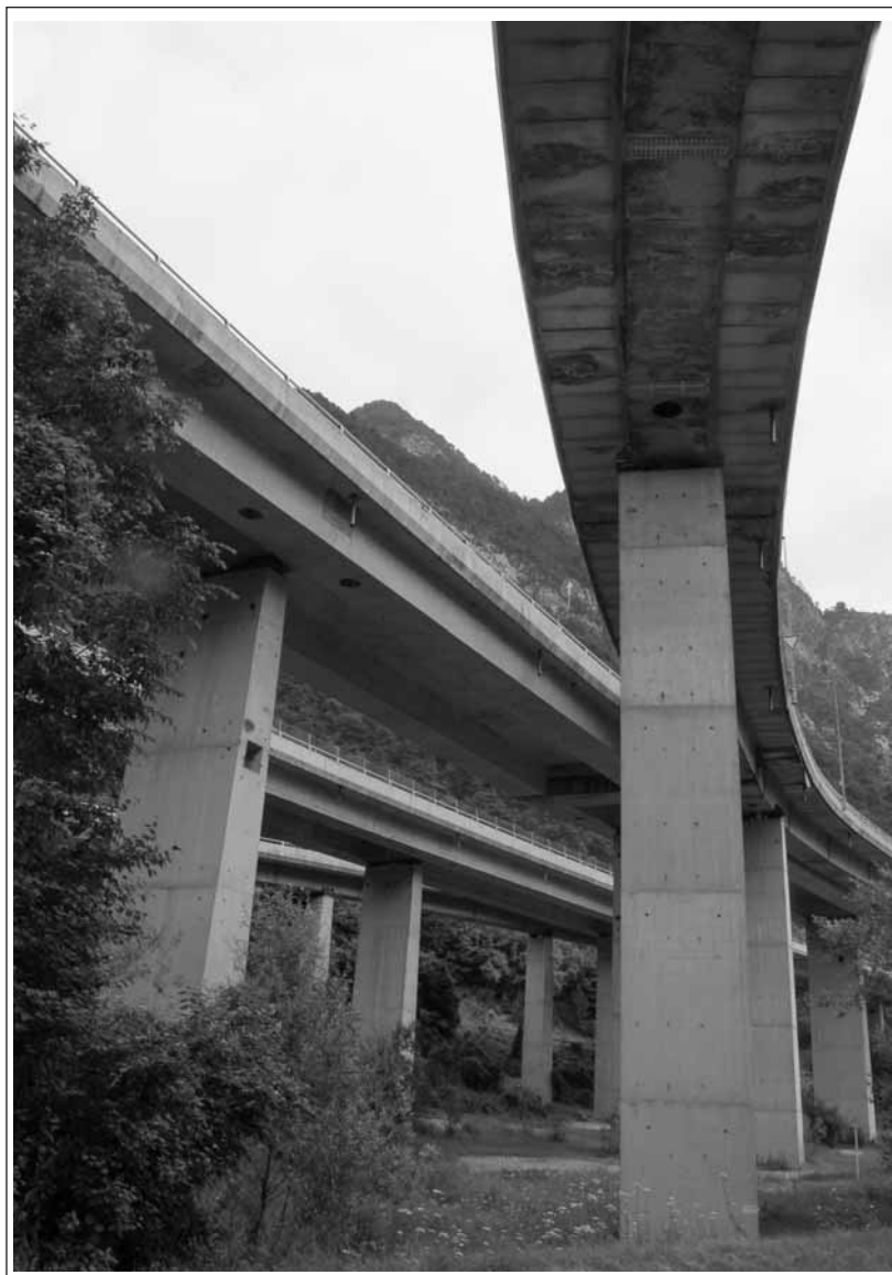
Opere di cementificazione in Val Canale
