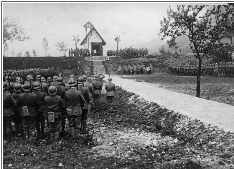
La solenne inaugurazione avvenuta in una nebbiosa mattina del 30 maggio 1917. Sul terrapieno, dove è stata edificata la cappella, è posizionata una grande scala che da alla piccola costruzione ancora più imponente. Ai suoi piedi la banda militare, ai bordi della strada che conduce alla cappella sono schierati i soldati italiani, con le armi in pugno, attendono l'inizio della funzione religiosa. (archivio Juren Mitja)
